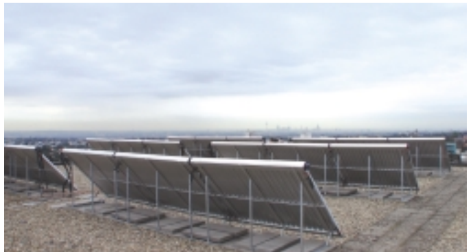
1. Großküche für ein Versicherungsgebäude bei Frankfurt (M)
