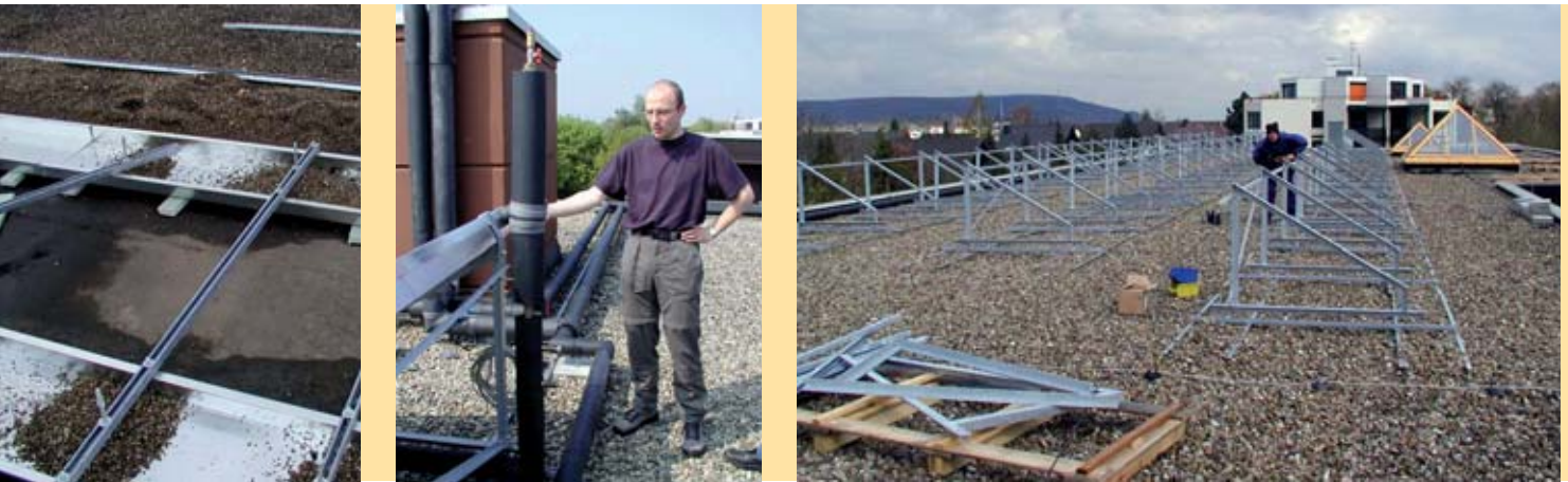
Abb. 13–15 Kollektoranlage Waldbronn im Bau. Foto: Hochschule Offenburg
