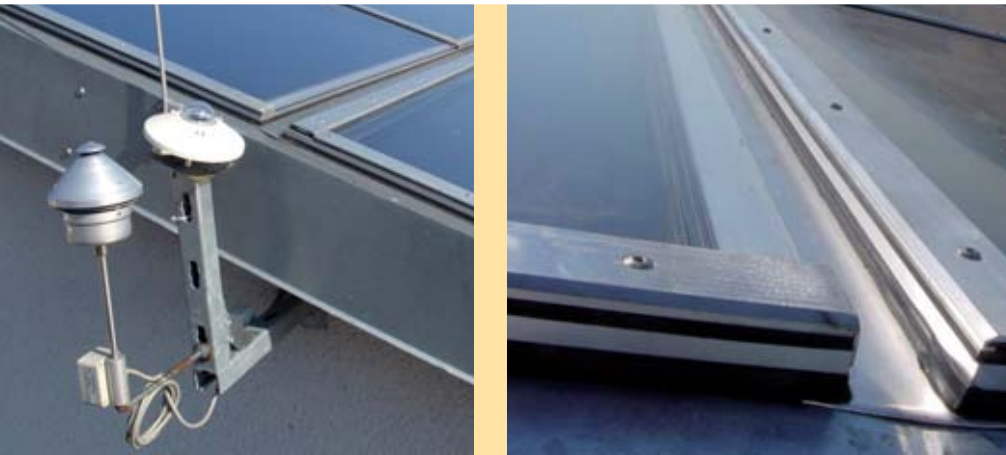
Abb. 20 Strahlungs- und Temperatursensoren. Foto: J. Bühl, Ilmenau
