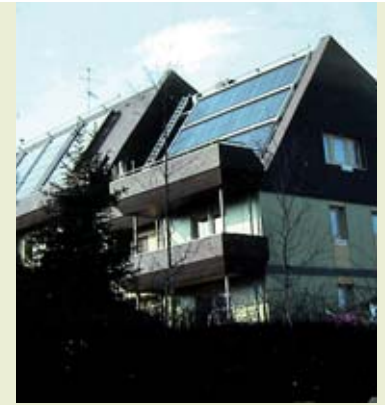
Abb. 29 Solarhaus in Freiburg: seit dreißig Jahren warmes Wasser und Raumwärme von der Sonne Foto: ISFH, K. Vanoli
